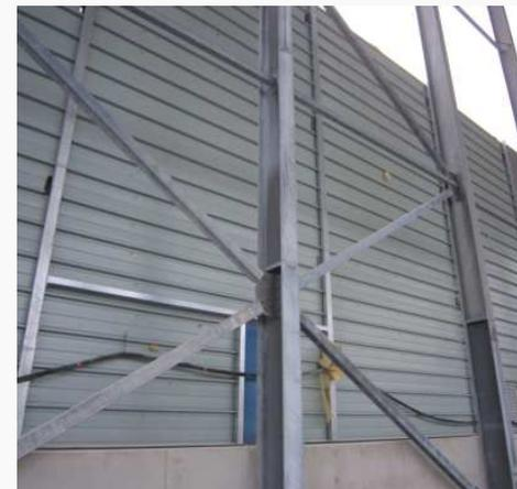
Charpente métallique entièrement articulée stabilisée en pignon et long pan par le biais de croix de saint André. La structure abritera un transtockeur automatisé indépendant de la structure et auto stable.
