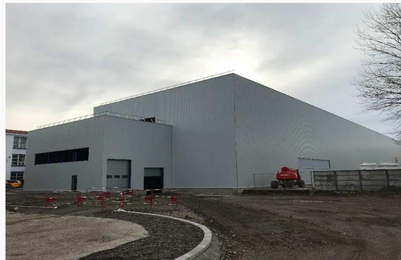
Construction d'un hall de stockage en structure métallique accolé à un bâtiment existant comprenant un plancher industriel et un transstockeur. Le poids de la charpente métallique est de 280 tonnes et celui de l'armature de génie civile est de 100 tonnes.
