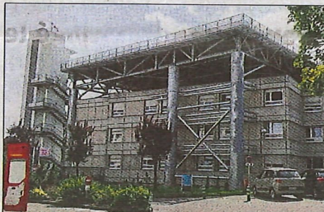
La construction de l'hélistation sur le toit de l'hôpital de Colmar est une des dernières réalisations de l'entreprise Sedime. DR
