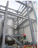
Construction d'un bâtiment de production, composé de plusieurs planchers d'une hauteur de 24 m en structure métallique.
