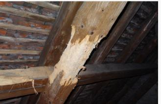
Remplacement de la couverture en tuiles, réparation et traitement de la charpente bois.
