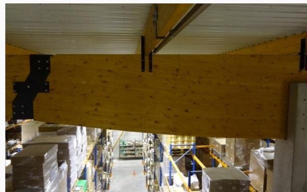
Renforcement de la charpente en bois lamellé-collé du bâtiment de logistique.
