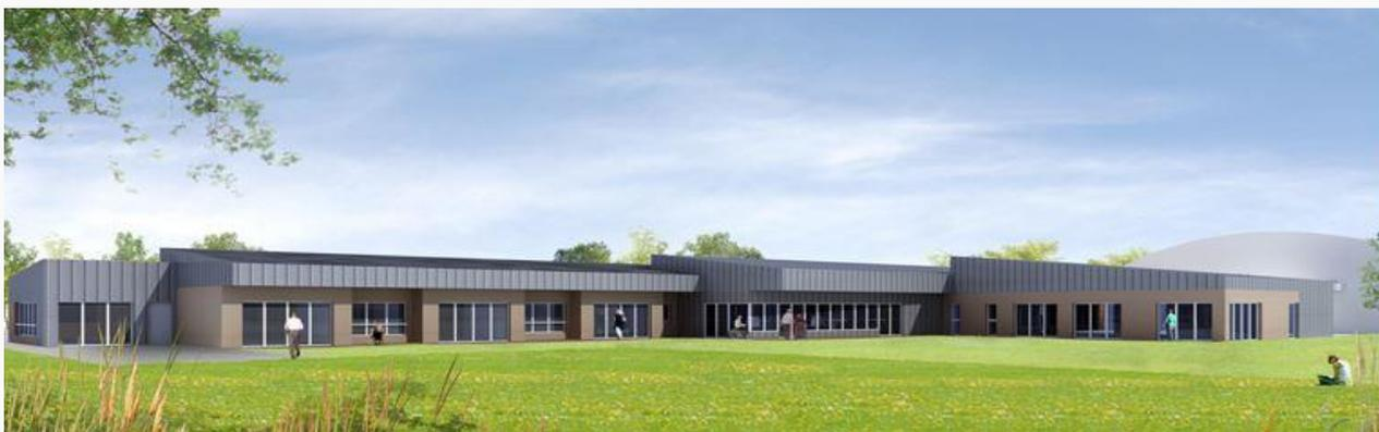
Construction d'une M.A.S de jour pour adultes et d'une section pour enfants pluri handicapés composé d'un bâtiment de plain-pied en structure béton couvert par une couverture Aluminium. La couverture sera supportée par une charpente en bois lamellé-collé
