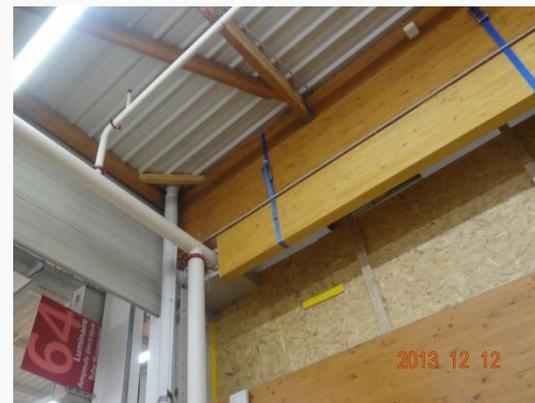
Renforcement de la charpente en bois lamellé-collé, en site occupé sans interruption d'activité, réalisation en 16 semaines et en travaux de nuit uniquement.
