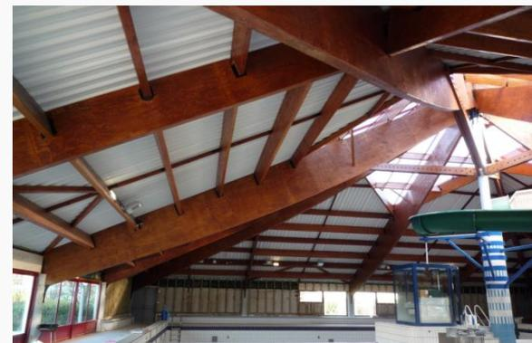
Réfection des charpentes, de l'étanchéité de la toiture et de la structure bois lamellé-collé.
