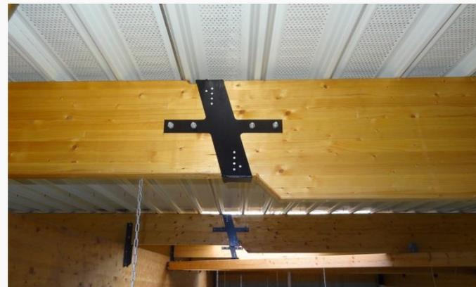
Diagnostic de la charpente en bois lamellé-collé et mise en sécurité du bâtiment. Consolidation des poutres sans interruption d'activité du maître d'ouvrage.
