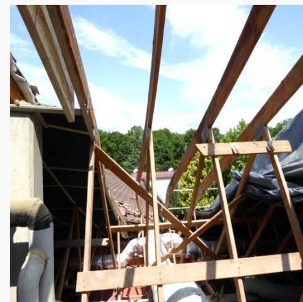
Suite à un sinistre, diagnostic et travaux de renforcement de la charpente bois et des murs en ossature bois en site occupé.
