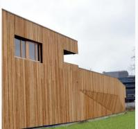
Construction d'un nouveau bâtiment pour le club d'aviron : hangar à bateaux et club-house structure métallique formant le squelette et habillée d'une peau isolée en ossature bois + bardage.
