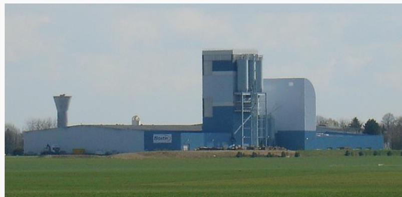
Réalisation de tours de mélange en structure métallique
