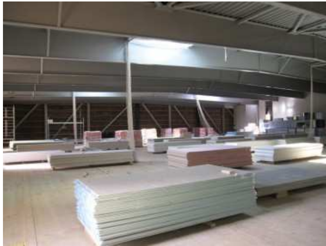
© Julien Rouby La salle d'escrime. La charpente métallique ne reste visible qu'à l'étage
