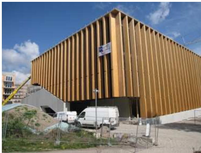
© Julien Rouby Les façades sud et est. La préfabrication des murs manteau de la façade a précédé la manutention et la pose des panneaux de 2,40 m de large, pour des hauteurs atteignant jusqu'à 16 m
