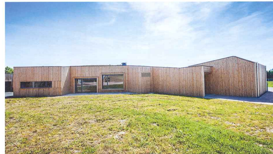
La commune d'Hadol (88), propriétaire de 1280 hectares de forêt, a choisi de valoriser son bois pour la construction du groupe scolaire. Cette réalisation de 1460 m 2 est en structure mixte bois-béton et utilise du sapin (charpente), du douglas (ossature et bardage) et du hêtre (menuiseries intérieures).
