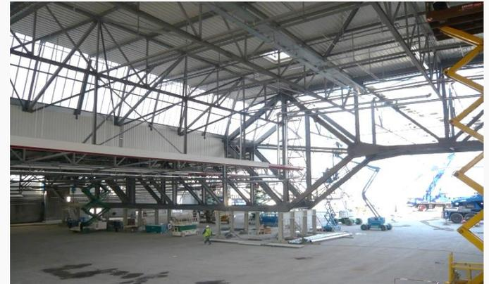
Cette mission a pour but de concevoir les ossatures métalliques du bâtiment WIDE WIDE BODY. Hauteur 21 m en partie courante et 27 m en zone centrale surélevée afin de permettre le passage de la queue de l'avion AIRBUS A 380.
