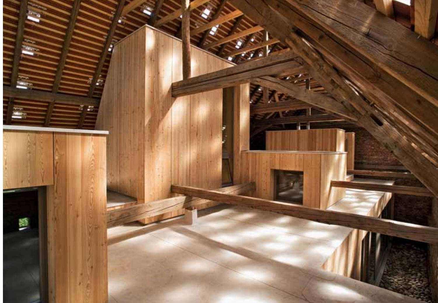
Les nouveaux éléments en bois du multi-accueil viennent s'insérer dans la grange évidée et restaurée, sans la combler. Les tuiles de verre et le pignon trans lucide laissent pénétrer la lumière, diffusée par les hauts jours ponctuant l'édifice.
