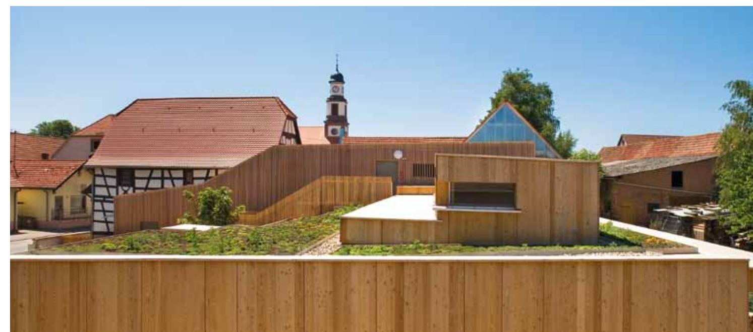
Une toiture à végétalisation extensive recouvre une partie de l'espace de circulation qui ouvre à l'est sur le jardin mitoyen à l'école communale.
