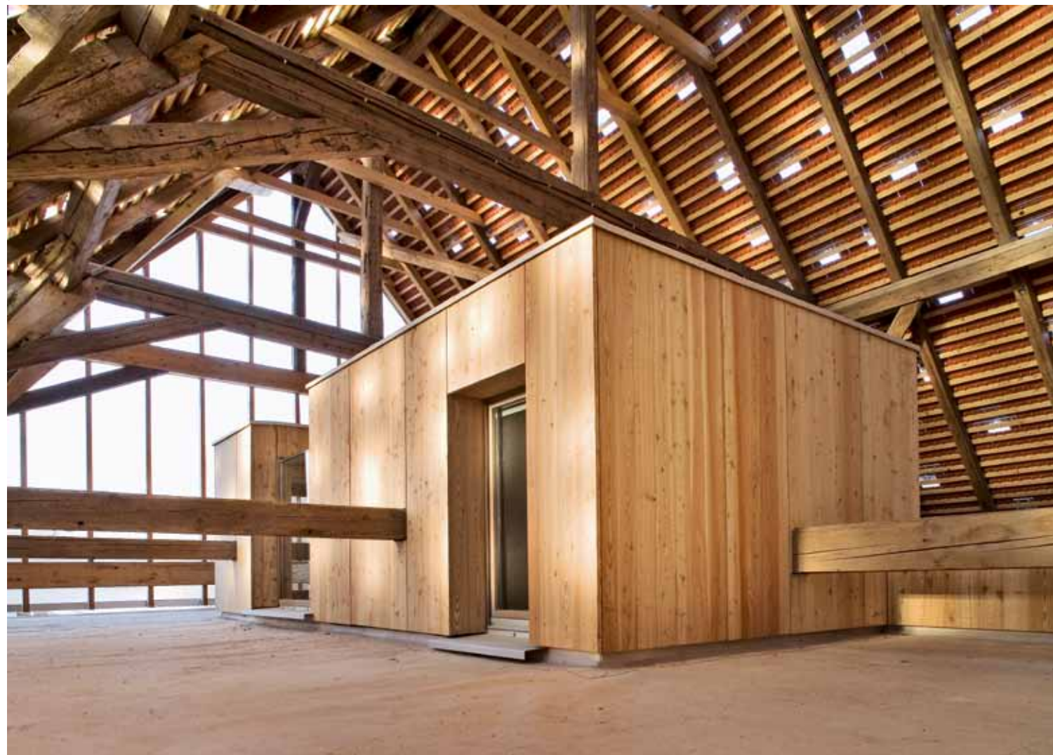
Les nouveaux éléments en bois du multi-accueil viennent s'insérer dans la grange évidée et restaurée, sans la combler. Les tuiles de verre et le pignon trans lucide laissent pénétrer la lumière, diffusée par les hauts jours ponctuant l'édifice.
