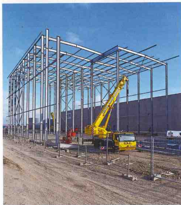
Les 1 600 tonnes de charpente métallique qui soutiennent les nouveaux bâtiments sont intégralement galvanisées.
