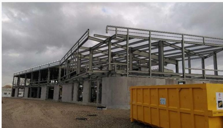
Construction d'une extension de bureaux en structure métallique accolée à un laboratoire existant spécialisé dans la recherche pharmaceutique et dans la conception de produits bio technologiques.
